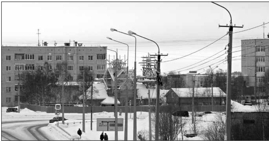
Строящаяся церковь Иверской иконы Божией Матери в Аптитах (ул. Кирова). Февраль 2016 г. Фото Д. А. Давыдова
