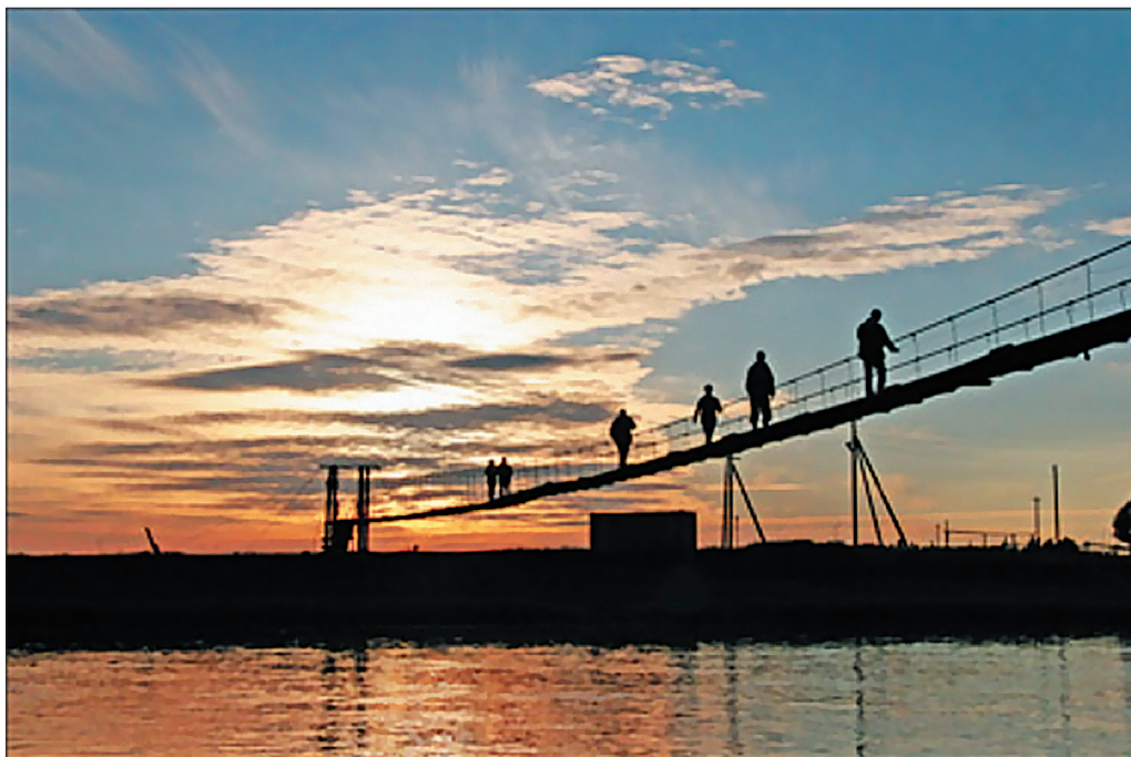
Мост через Пижму. Фото С. Зиновьева, июль 2006 г.
